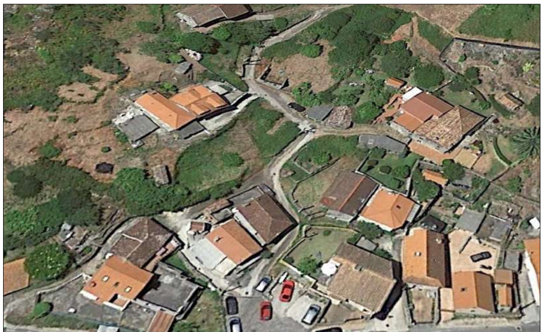
Vial de Fuxiño en el que se ha previsto ejecutar la obra
